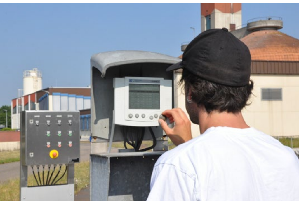
Teammitglied Dennis Schober überwacht Tests an stehendem Brauchwasser aus der Kläranlage in Landau.
