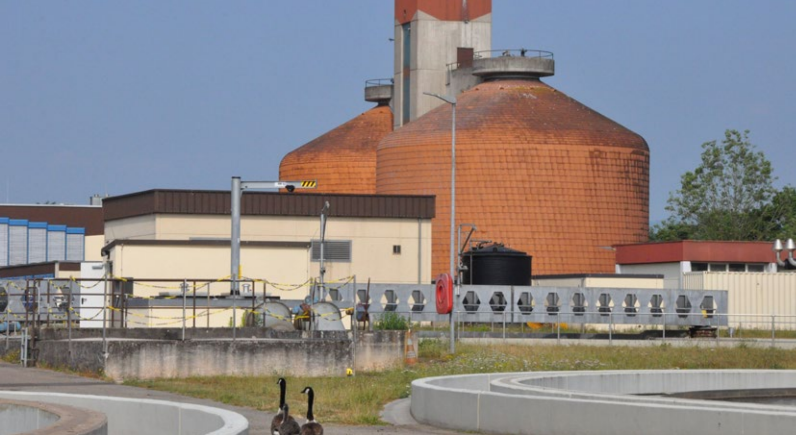
In der Kläranlage in Landau erprobt das Team von Katrin Schuhen die allmähliche Überführung der Laborergebnisse in die Praxis. Dabei arbeiten die Wissenschaftler nicht nur an ihrem Verfahren, sondern klären auch dessen Integration in die bestehende Technik.
