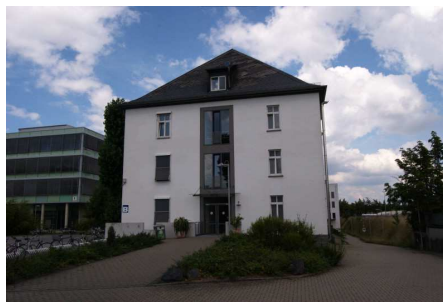
Abbildung 3.11: Beispiel für die Teilmenge eines Gebäudemodells. Hier werden nur die Semantikelemente und ihre direkten Verbindungen zur Geometrie, der in Abbildung 3.11(b) zu sehenden Fassade, gezeigt.
