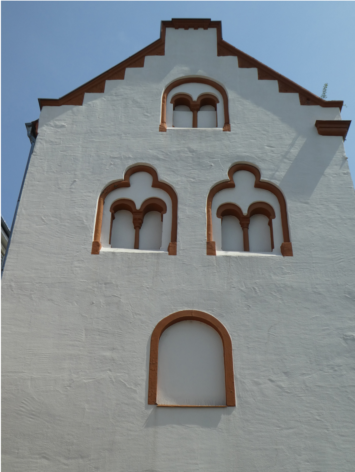
Abbildung 4: Boppard, Templerhaus, Westfassade (Giebelseite).
