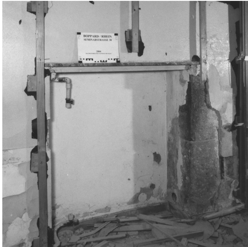
Abbildung 15: Boppard, Templerhaus, monolithisch gerahmte Öffnung auf der Nordseite. Foto nach Abriss des anliegenden Nachbargebäudes (2004).
