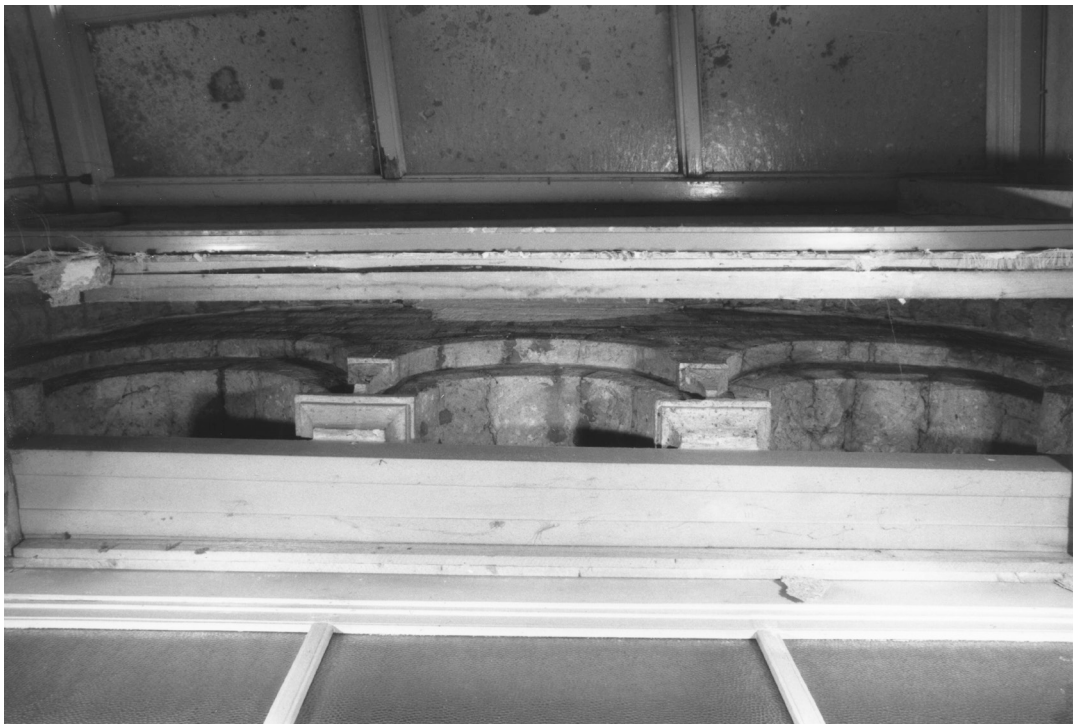
Abbildung 18: Boppard, Templerhaus, oberer Abschluss einer Triforie im 2. Obergeschoss der Nordwand. Gut sichtbar ist die Konstruktion aus Tuffsteinen.
