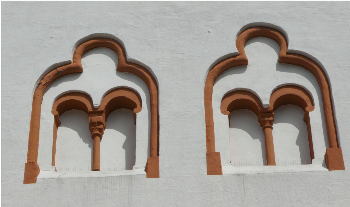
Abbildung 5: Boppard, Templerhaus, 2. Obergeschoss der Westseite mit Biforien in Kleeblattbogenblende.
