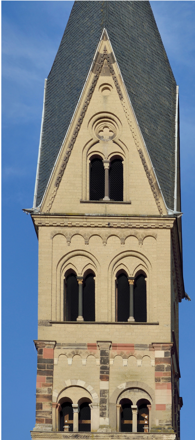
Abbildung 28: Koblenz, St. Kastor, Westfassade des Nordwestturms.
