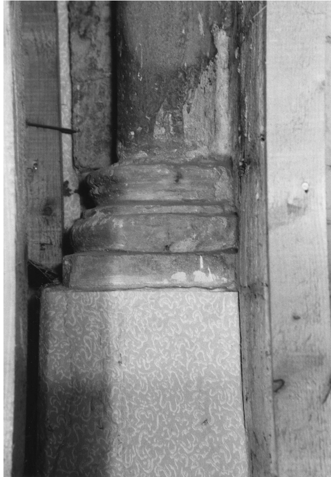
Abbildung 17: Boppard, Templerhaus, Basis (mit attischem Profil) eines Rundwulstes im 2. Obergeschoss der Nordwand.
