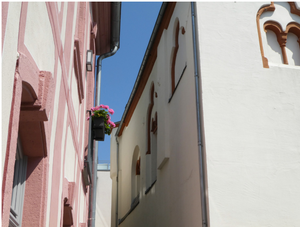
Abbildung 14: Boppard, Templerhaus, Ansicht von Nordwesten.
