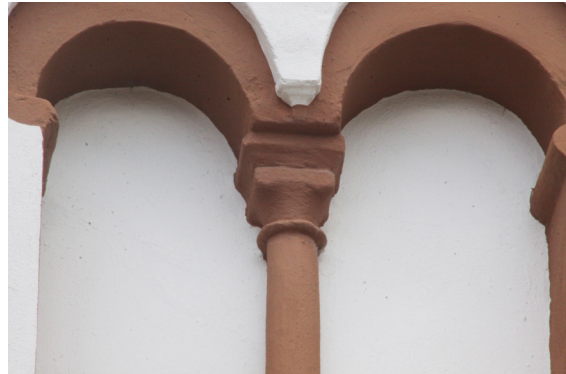
Abbildung 7: Boppard, Templerhaus, Detail der rechten (südlichen) Biforie des 2. OG der Westseite.
