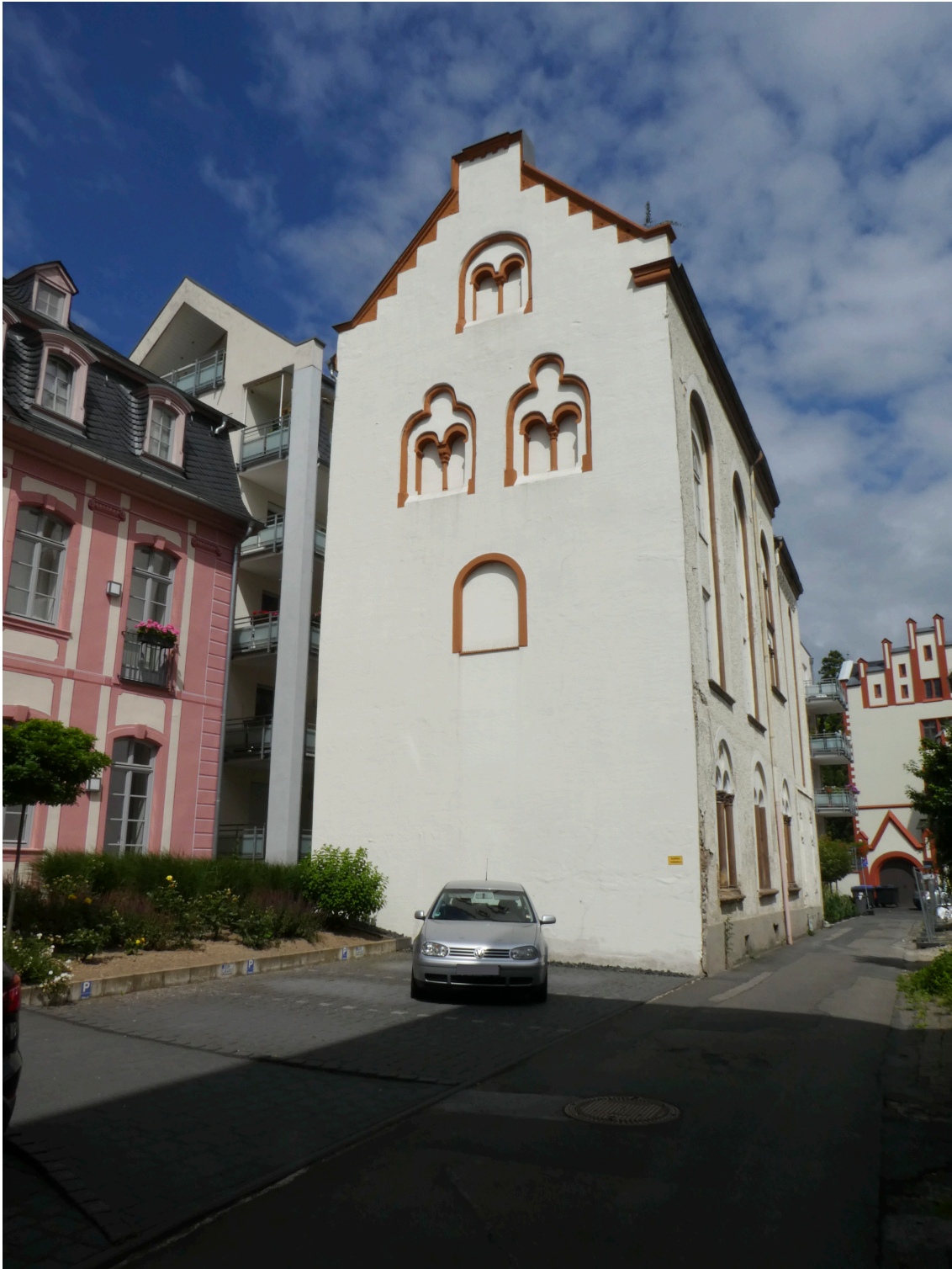
Abbildung 2: Boppard, Templerhaus, Ansicht von Südwesten.
