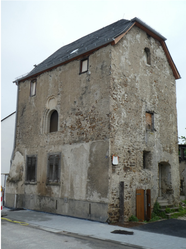
Abbildung 44: Koblenz-Horchheim, Präsenzhof des Florinstifts, Ansicht von Südwesten.
