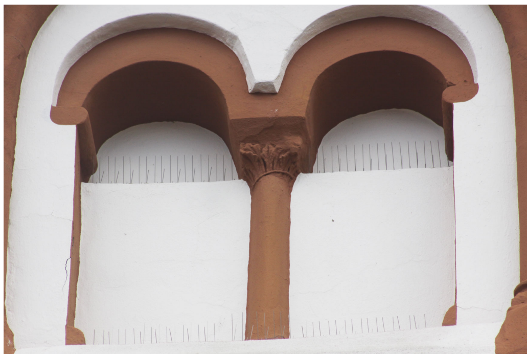
Abbildung 9: Boppard, Templerhaus, Detail der Biforie des Dachgeschosses der Westseite.
