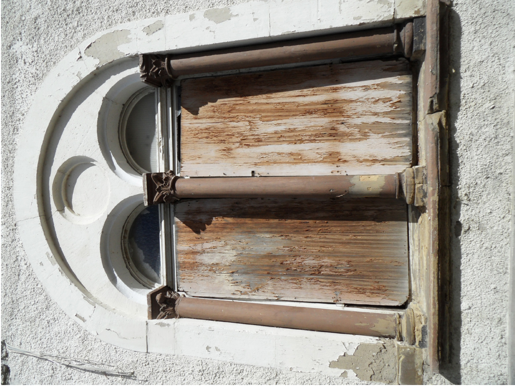
Abbildung 11: Boppard, Templarhaus, Erdgeschossfenster der westlichen Achse der Südseite.
