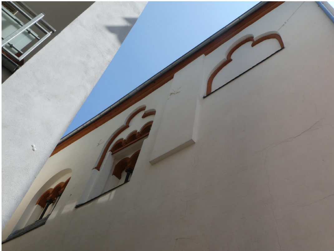
Abbildung 15: Boppard, Templerhaus, monolithisch gerahmte Öffnung auf der Nordseite. Foto nach Abriss des anliegenden Nachbargebäudes (2004).
