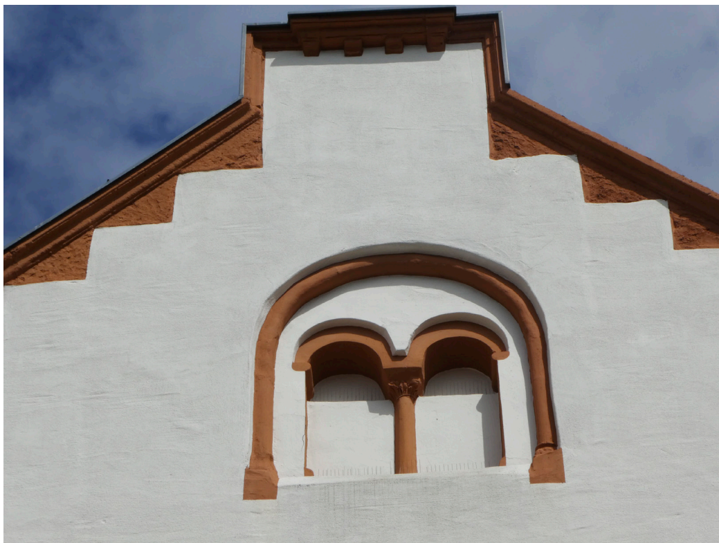
Abbildung 8: Boppard, Templerhaus, Dachgeschoss der Westseite mit Biforie in Rundbogenblende.
