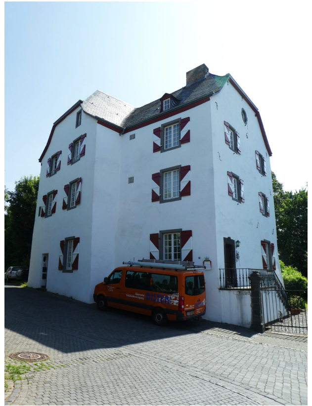
Abbildung 47: Koblenz-Rübenach, Wohnturm der von Eltz-Rübenach, Ansicht von Nordwesten.
