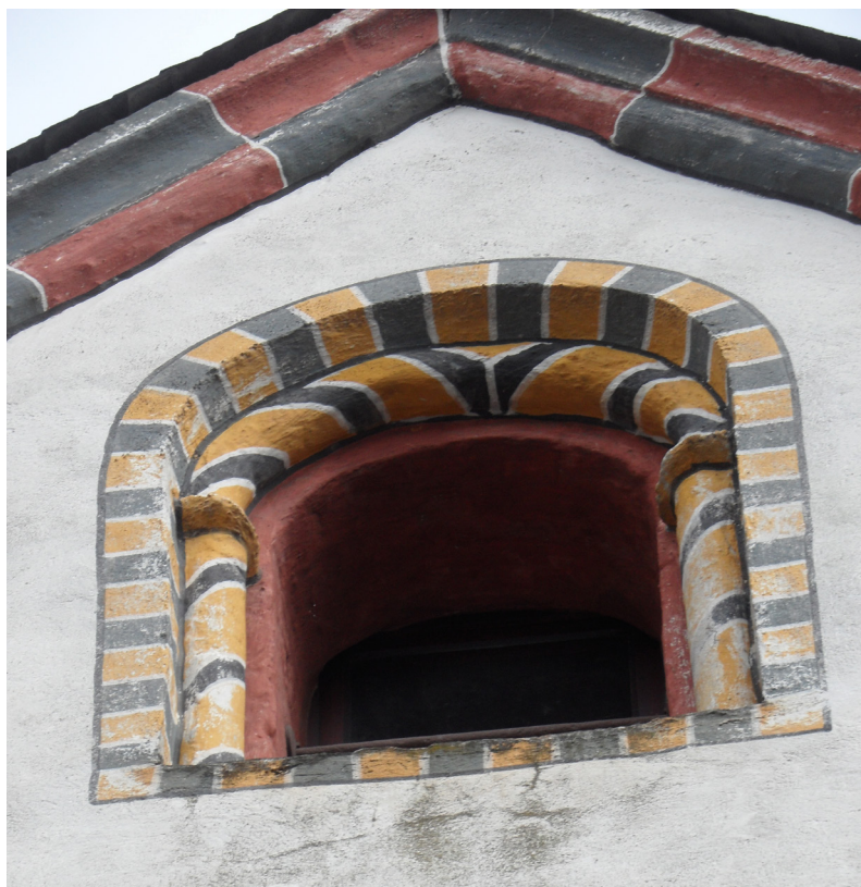
Abbildung 38: Treis-Karden, Haus Korbisch, Rundbogenfenster der Westseite.
