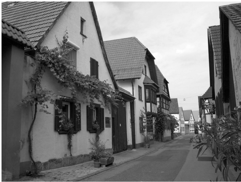
Foto Ple 1: Ortsmitte Oberhofen; Fachwerkhäuser mit rechteckigen Toreinfahrten, Vordächern und Fassadenbegrünungen.
