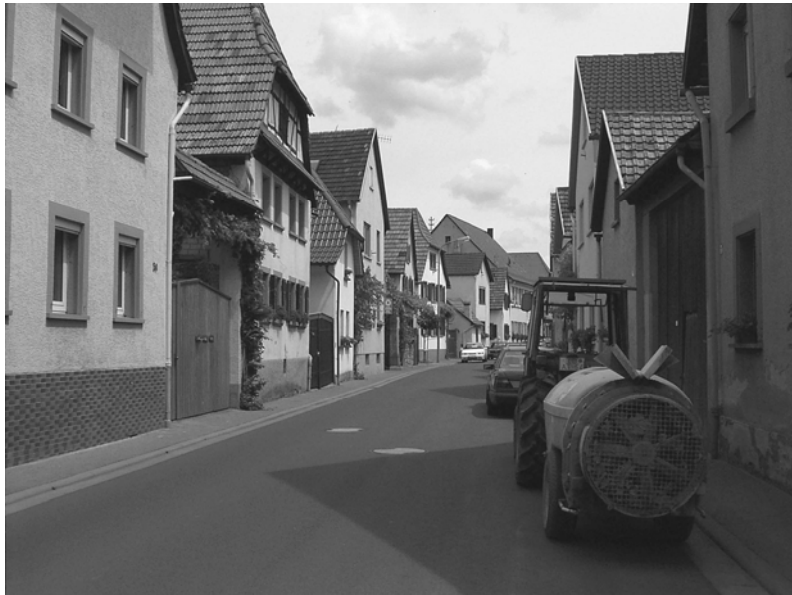
Foto Gök 2: Häuserzeile in der Hauptstraße; giebelständig; kleine Vordächer; Hausbegrünung.
