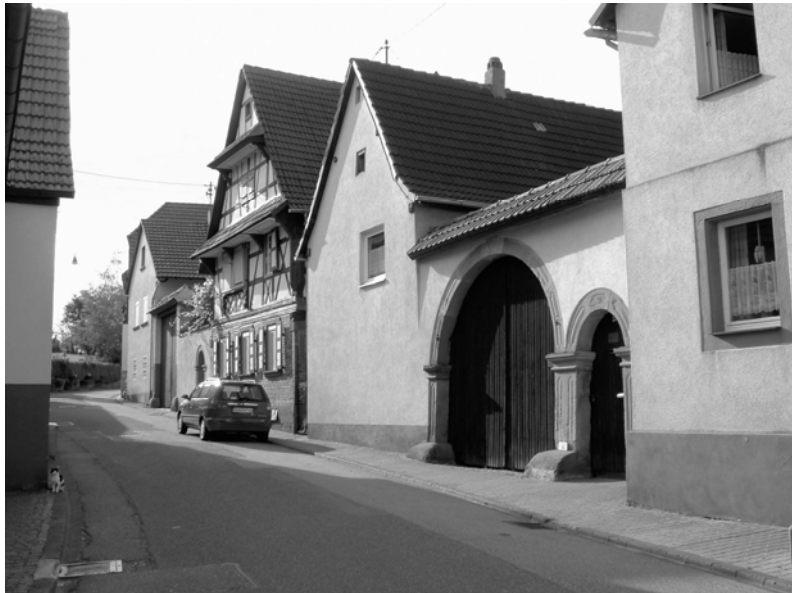
Foto Ple 2: Fachwerkhaus (Oberhofen) mit Vordächern; rundbogige Toreinfahrt (ziegelgedeckt!).
