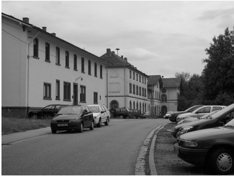
Foto Win 7: Bahnhof; sehr frequentiert; Außenfassade renovierungsbedürftig.
