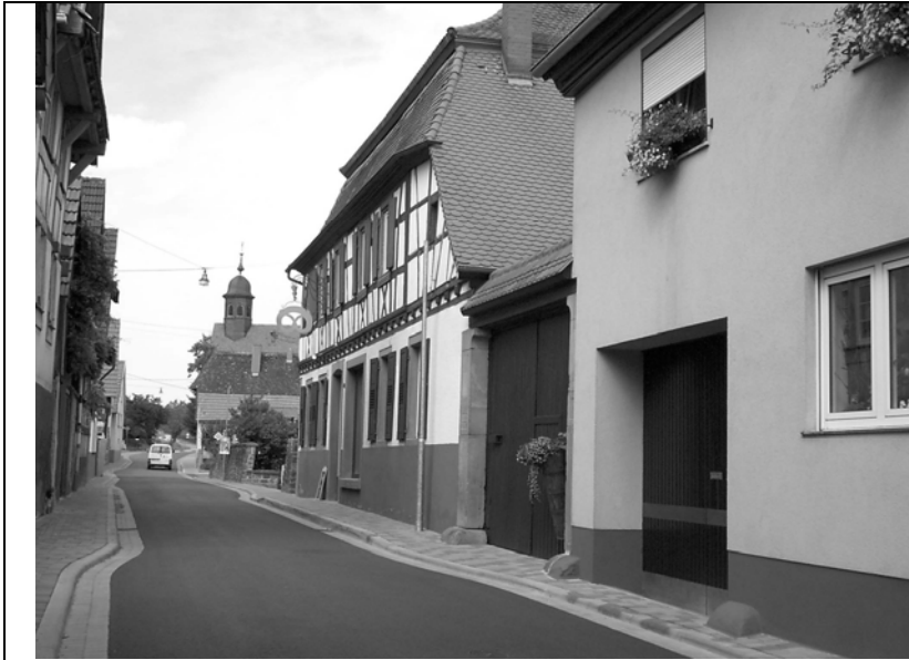
Foto Ple 4: Fachwerkhaus (Pleisweiler) mit waagrecht gedeckter Toreinfahrt.
