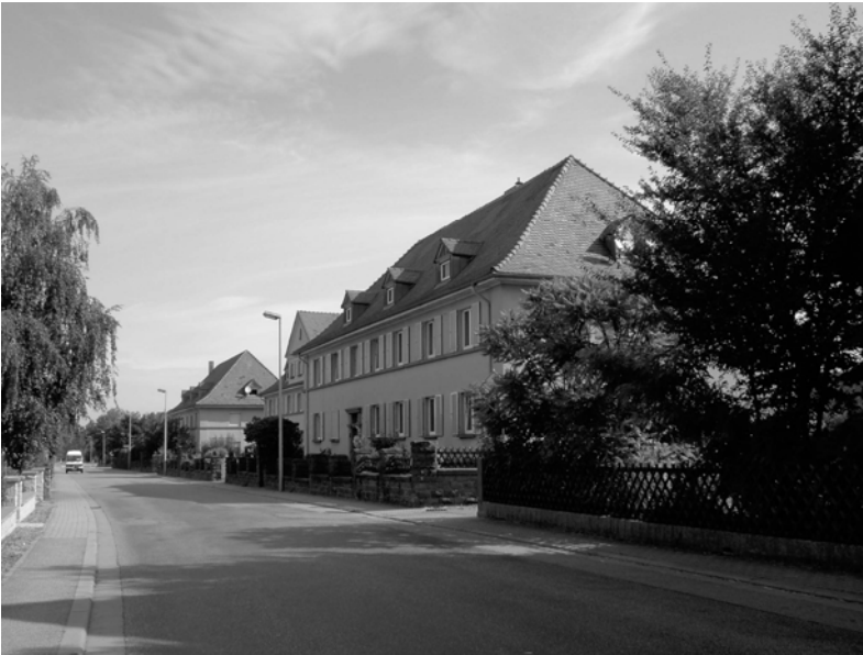
Foto Win 6: Bauten (Zoll) aus der Inflationszeit Ende der 1920er Jahre; entlang der Grenze zu Frankreich überall in gleichem Baustil errichtet (auch in Ludwigswinkel und Kapsweyer).
