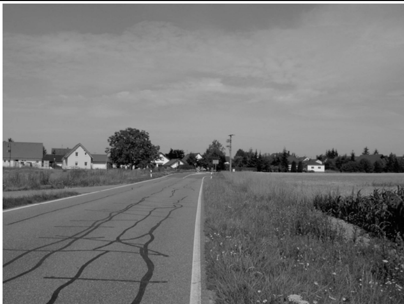
Foto Hay 8: Ortseingang im SE; Neubaubereich; Straße breit angelegt; keine grünen Sichtbarrieren.
