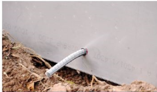
Moniereisen zur Diebstahlsicherung im Boden.
