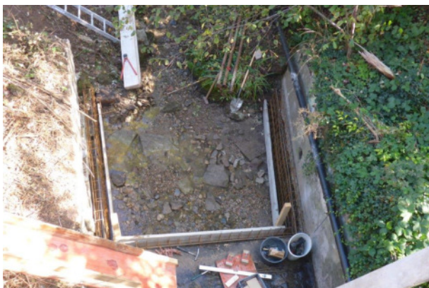
Abbildung 39: Aufsicht auf die Ertüchtigung eines Durchlassbauwerkes unter einer Straßenbrücke als vorbereitende Maßnahme für den Bau einer ad hoc-Sperre (Baden-Württemberg). Vor der Installation der Verblechungen musste der beschädigte Absturz und die brüchigen Seitenwände durch Betonarbeiten saniert werden, um ein Funktionalität zu gewährleisten. Die Arbeiten wurden durch den kommunalen Bauhof durchgeführt. (Foto: Bauhof der Stadt Löwenstein).
