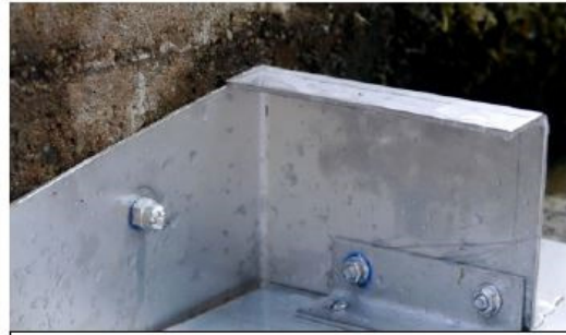
Befestigung an Betonmauer mit verklebten Hutmuttern.
