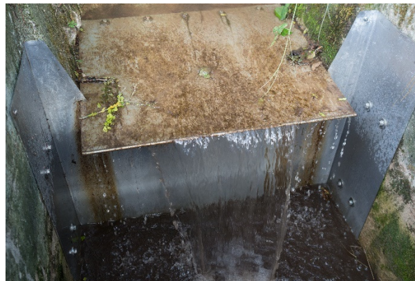
Abbildung 38: Detailansicht der Verblechung mit Überkrragung des Absturzes und Teilverkleidung der Wände. (Foto: Verfasser)
