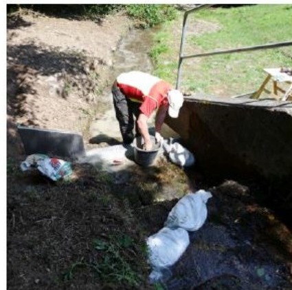
Baustelleneinrichtung mit wasserableitenden Sandsäcken.
