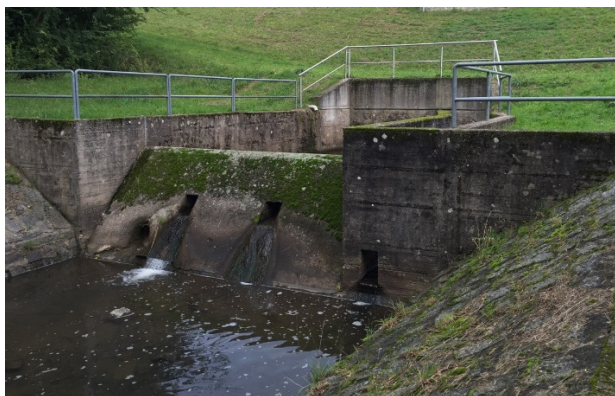
Abbildung 43: Auslaufbauwerk eines Hochwasserrückhaltebeckens im Dauerstau vor der Modifizierung zur Krebs Sperre. (Foto: R. Hennings)
