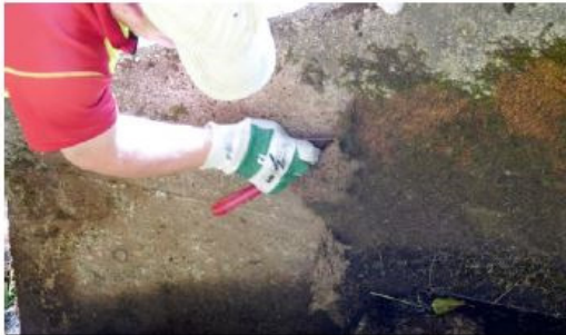
Betonwand von Moos befreien.
