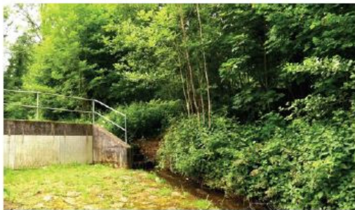
Anlage vor Beginn der Manahme.
