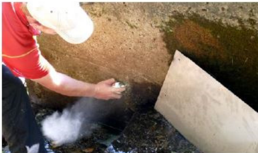
Bohrloch ausblasen mit Druckluft.
