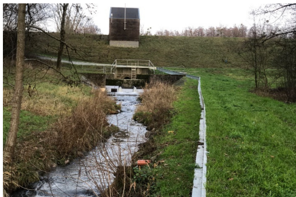
Abbildung 45: Installierte Barriere aus Amphibienleitblechen entlang des Ufers im Unterwasser auf über 100m Länge, um ein Umwandern der Sperre über Land zu verhindern. Über die Hälfte der Kosten fielen durch die Leiteinrichtung an. Die Leiteinrichtung bedarf einer regelmäßigen Unterhaltung durch Mähen und Entfernen von Gehölzen, um dauerhaft ihre Funktion zu erfüllen (Hennings, 2019, schriftliche Mitteilung). (Foto: R. Hennings)
