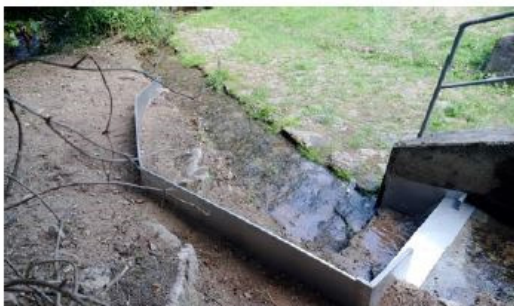
Ansicht in Fließrichtung.
