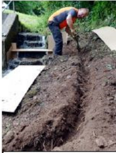
Verlauf des Graben.
