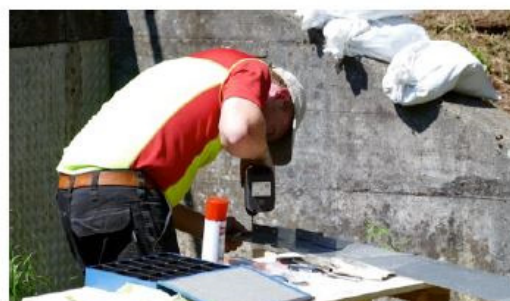
Bleche vorbohren und Bohrlöcher ansenken.
