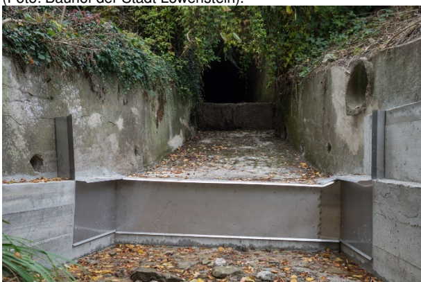
Abbildung 41: Blick vom Unterwasser auf die fertiggestellte Krebsperre. Deutlich zu erkennen sind die sanierten Teilbereiche sowie die angebrachten Verblechungen aus Edelstahl. Die Anbringung der Verblechungen erfolgte durch einen Flaschner. (Foto: Verfasser)
