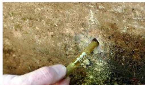
Klebedübel einbringen.
