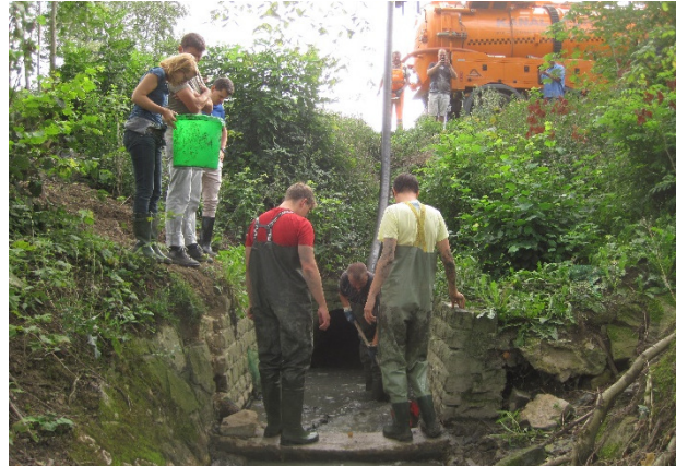
Abbildung 32: Entfernung von Restwasser und Schlamm aus dem Auslauf des trockengelegten Stillgewässers in den Vorfluter, der ebenfalls mit F. limosus besiedelt war. (Foto: M. Pfeiffer)
