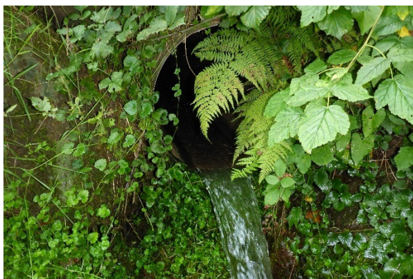
Abbildung 48: Krebs Sperre mit funktionaler Einschränkung auf Grund der Sukzession der Ufervegetation. Aufwärtswandernde NICS können über die Pflanzen in den Rohrdurchlass klettern oder die Sperre über Land umwandern. (Foto: B. Schmieder)
