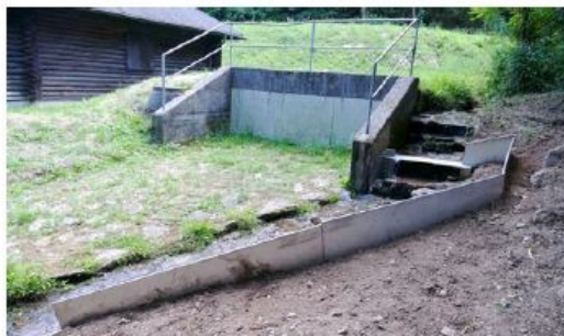
Gesamtansicht mit Hochwasserschutzteinrichtung.
