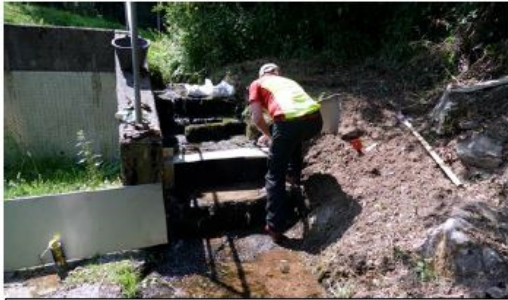
Mit wasserfestem Beton Öffnungen schließen.
