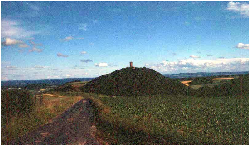
Bild 4: Burgruine Olbrück auf der Leucit-Phonolith-Kuppe (Blick vom Schorrberg, 27.06.1997)
