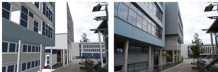
Abbildung 49: G-Gebäude links, Bibliothek rechts (GPS-X: 397495; GPS-Y: 5580105; Kompass: 92°)
