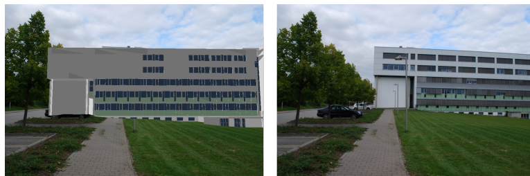
Abbildung 55: EF-Gebäude mit fehlenden Fenstern (GPS-X: 397414; GPS-Y: 5579949; Kompass: 22°)
