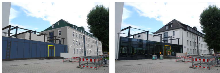
Abbildung 53: neue Mensa links, B-Gebäude rechts (GPS-X: 397525; GPS-Y: 5580013; Kompass: 160°)
