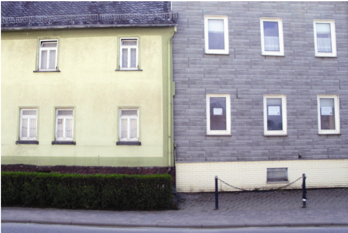
Abb. 86: Wohnungsleerstände an der B 8 in Wallmerod
