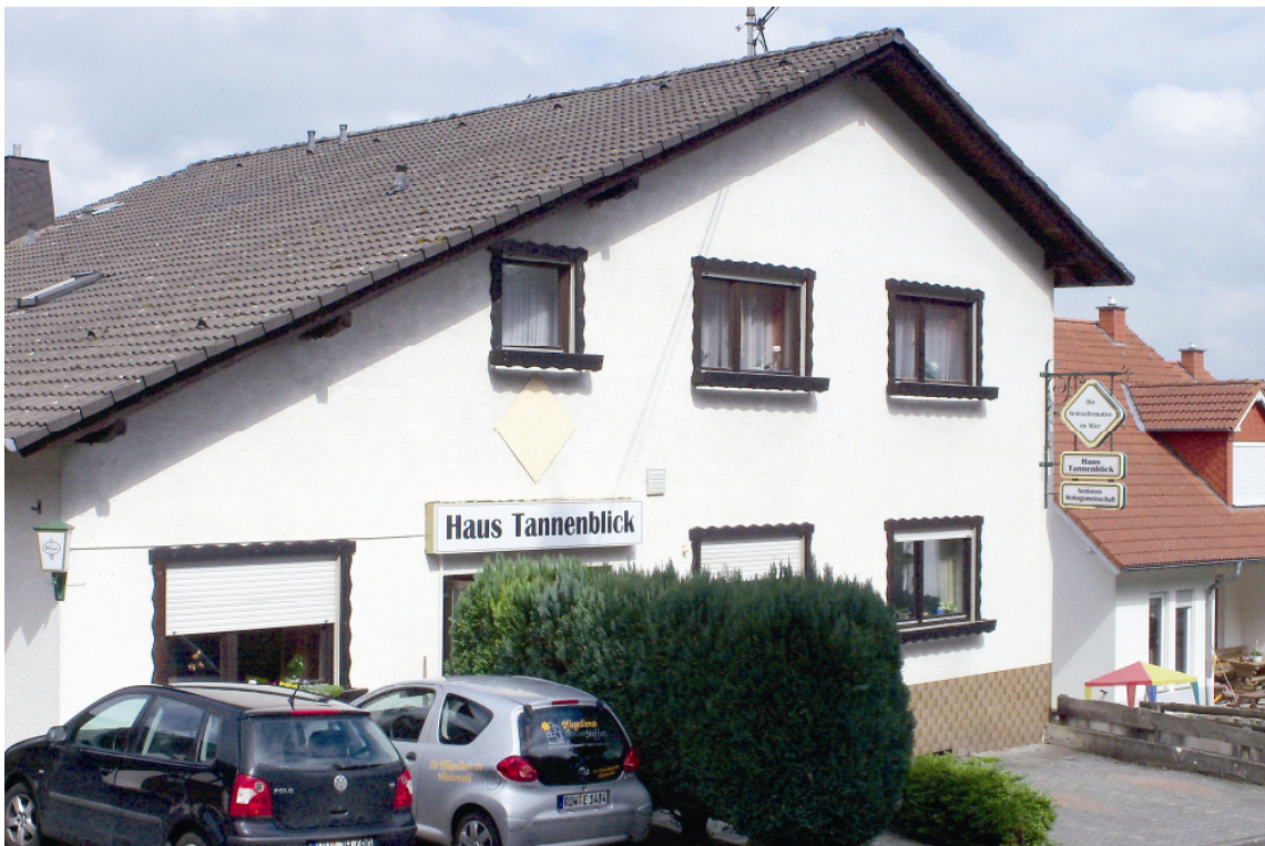
Abb. 85: Seniorenwohnheim (ehemalige Gaststätte) in Bilkheim
