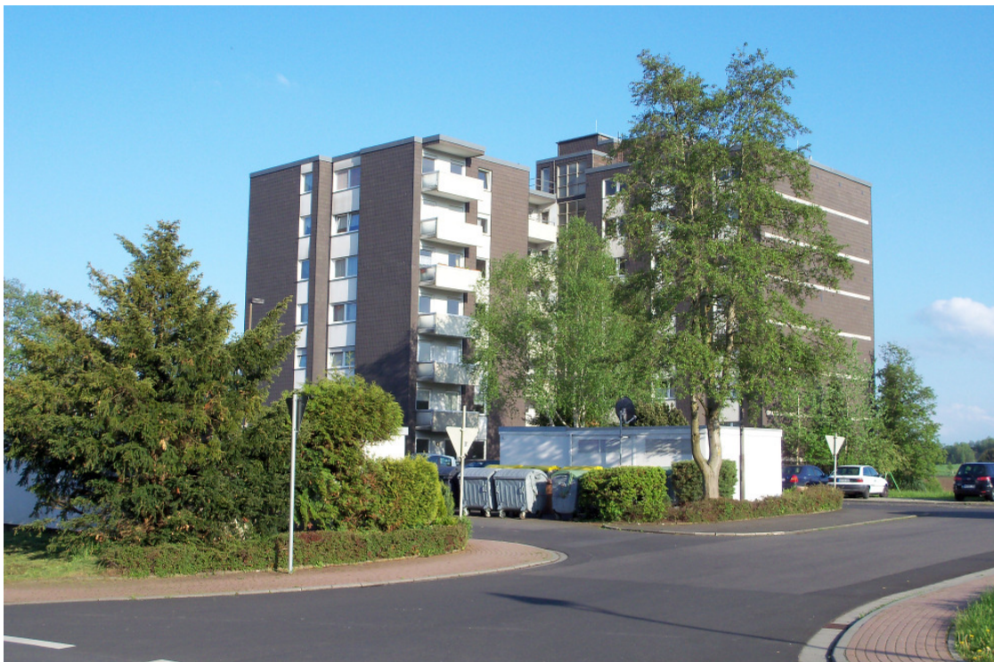
Abb. 80: Hochhaus im Südring, Dernbach
