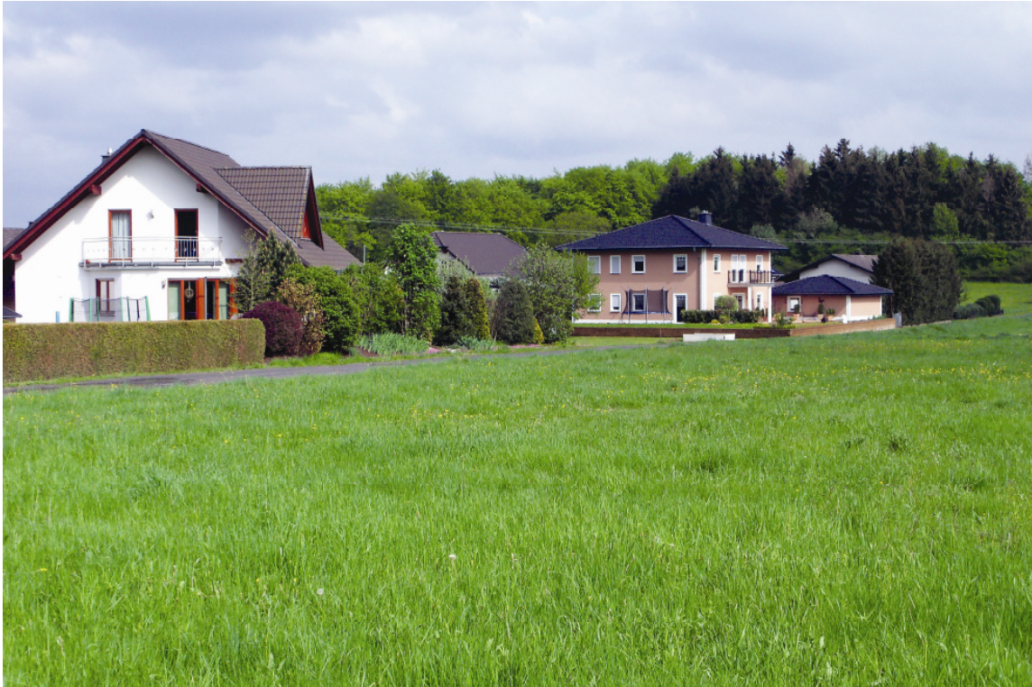
Abb. 87: Teil des Neubaugebiets Untere Dörrbach in Wallmerod
