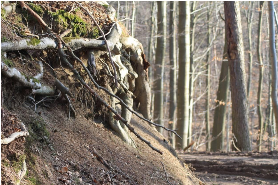
Abb. 3.21: Durch Böschungserosion der Innenböschung freigelegter Wurzelstock, Wassenacher Wald.
