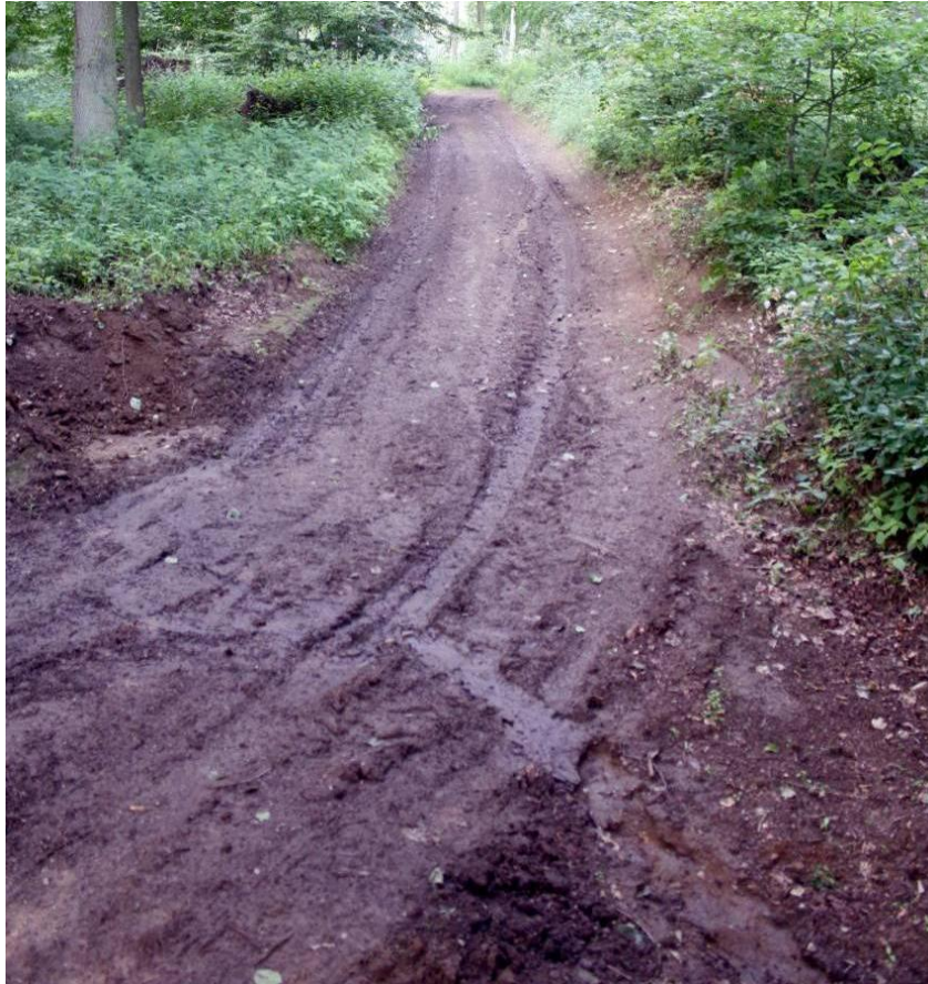
Abb 5.6: Beispiel eines Weges der Kategorie 2, Aufnahme nach Befahrung bei vorgesättigtem Oberboden im Juni 2012. Im Vordergrund ist im Kurvenbereich aus der Fahrspur geflossener Rillenabfluss zu erkennen.
